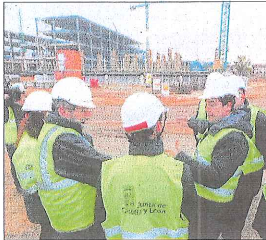
Fernández Mañueco visitó las obras del nuevo hospital. ICAL
